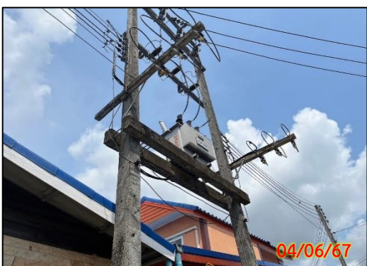
รูปที่ 2.2-17 หม้อแปลงไฟฟ้าแรงสูงภายในโครงการ
